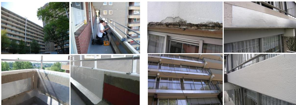
ZLA è fornito in rotoli da 250 mm di larghezza e da 25 m di lunghezza. Dopo l'applicazione, se richiesto per motivi estetici, ZLA può essere provvisto di un rivestimento di finitura di un colore qualsiasi secondo specifica richiesta del cliente. Il controllo del sistema può essere eseguito (se richiesto) secondo la norma europea EN 12696
