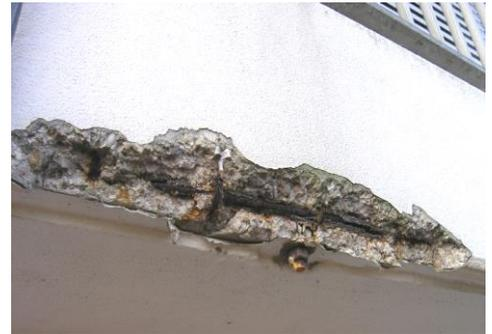
**La normativa Europea EN 12696 "protezione catodica dell'acciaio nel calcestruzzo" esplicita i principi di protezione catodica e la sua applicazione all'acciaio nel calcestruzzo.**
