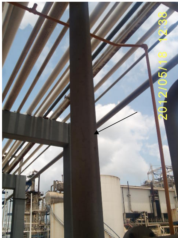
LINEA DE GAS NATURAL ALIMENTACION A LA PLANTA DE AMONIACO N° 4
