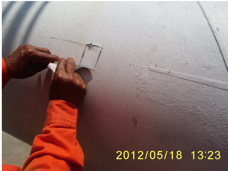
CORTE DE VENTANA PARA MUESTRA DEL ESTADO ESTRUCTURAL EN LA LINEA DE SUCCION DE AGUA DE ENFRIAMIENTO EN LA PLANTA DE AMONIACO N°6
